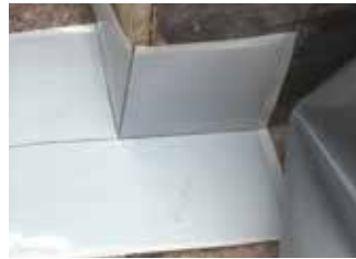
Köşe detaylarının yerleştirilmesi
