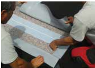
Yalıtım bandı uygulaması
