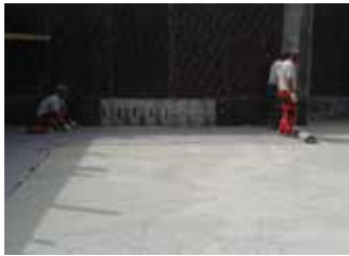
Yüzey hazırlığı ve keçe serilmesi
