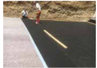
Membranın yerleştirilmesi ve birleştirilmesi
