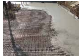
Beton dökümü
