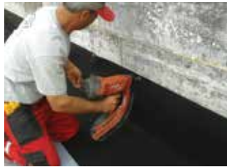
Yalıtım membranının sabitlenmesi
